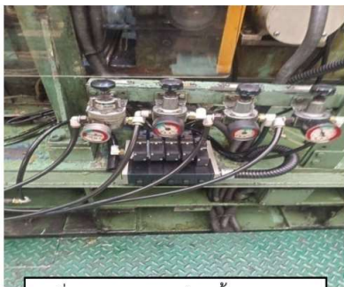
เปลี่ยนฐานและวาล์วลมทั้งชุด SE-27
