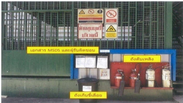
ห้องจัดเก็บสารเคมีและวัตถุอันตรายแยกออกจากสถานที่ทำงาน
