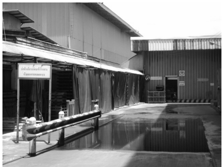
บ่อล้างล้อรถก่อนเข้าโรงงาน
